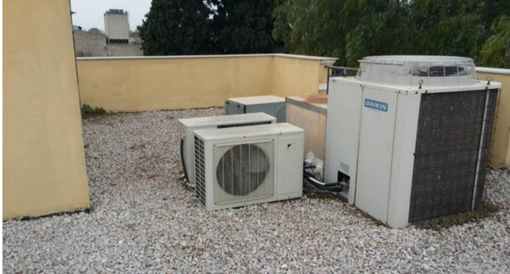
Εικ. 3: Δώμα του κτηρίου Ιασεμίδα
