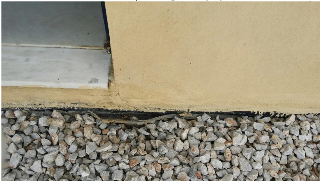
Εικ. 4: Δώμα του κτηρίου Ιασεμίδα
