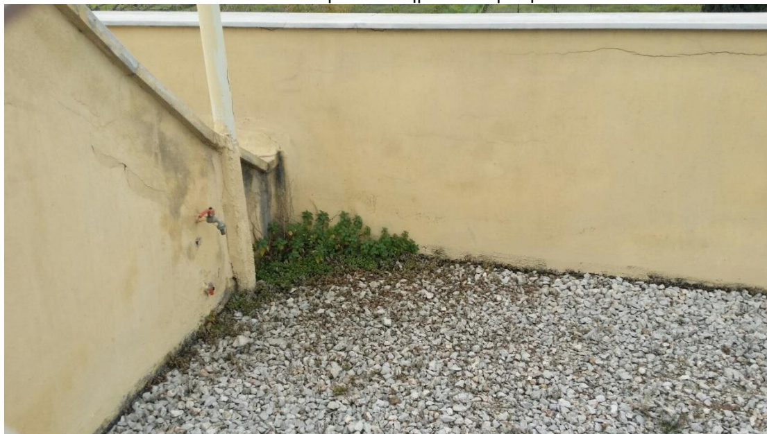
Εικ. 5: Δώμα του κτηρίου Ιασεμίδη
