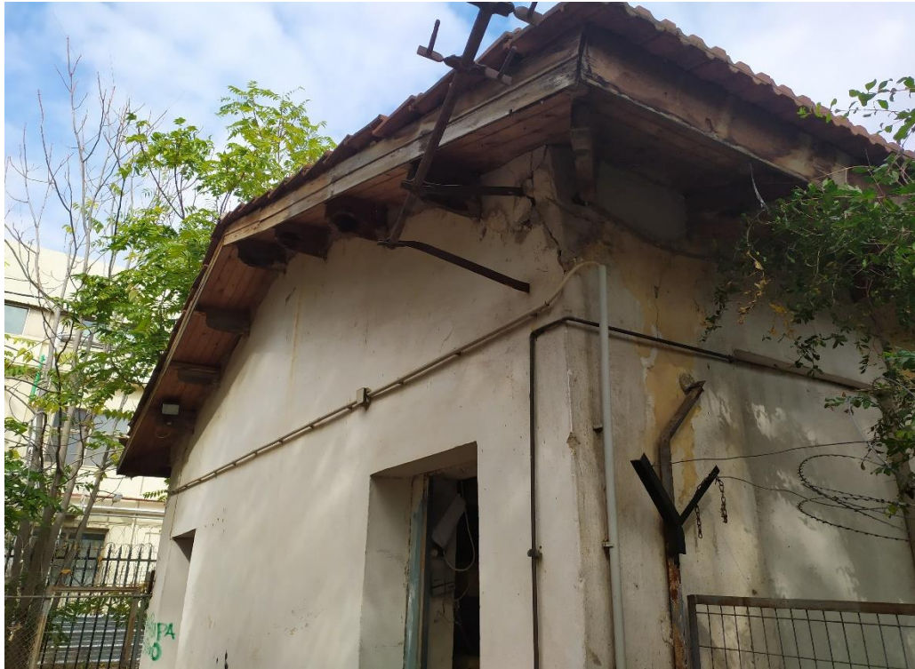
Εικ. 2: Κτήριο Πτηνοτροφείου - Παραγωγής Αυγών
