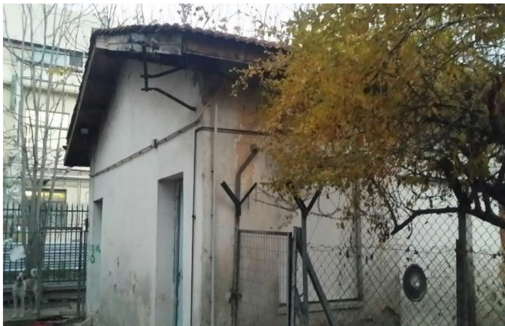
Εικ. 1: Κτήριο Πτηνοτροφείου - Παραγωγής Αυγών
