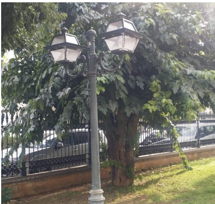
Φωτό 2: Εξωτερικό φωτιστικό περιβάλλοντος χώρου κτ. Παπαδάκη
