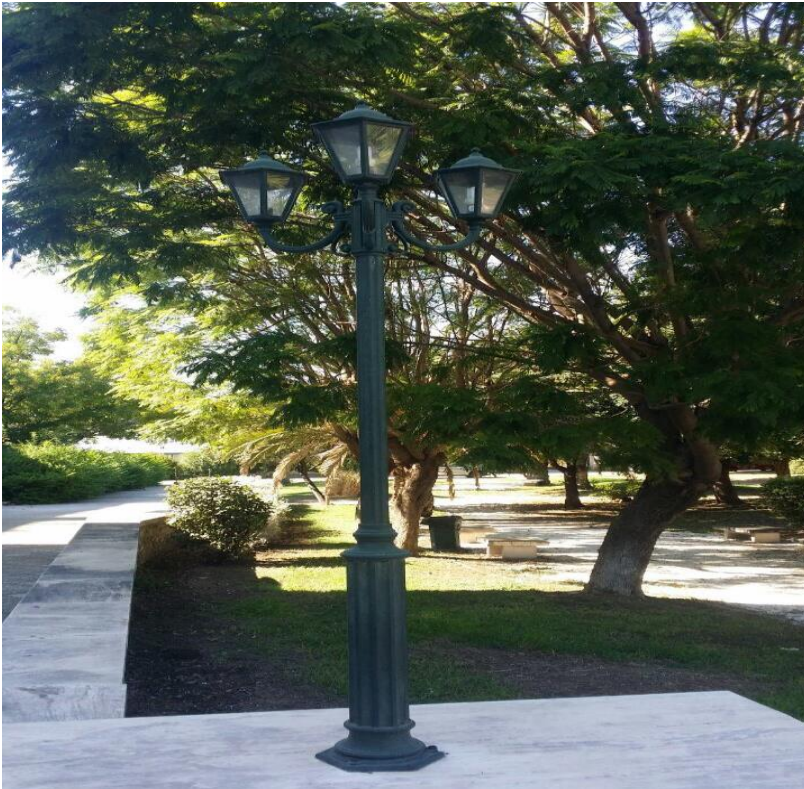
Φωτό 3: Εξωτερικό φωτιστικό περιβάλλοντος χώρου κεντρικού κτηρίου
